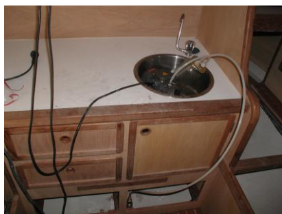
Sugeslange fra pumpen
